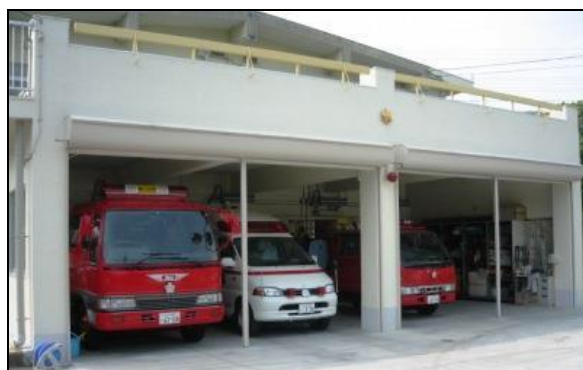
日立消防署西部機関員派出所
