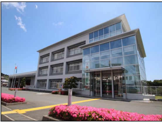
日立市消防本部・日立消防署
