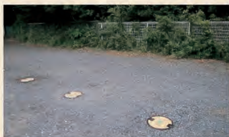
マンホールトイレ設置前
