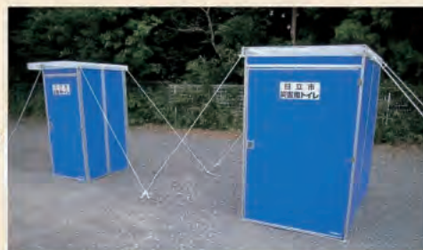
マンホールトイレ設置後
