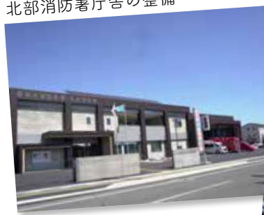
北部消防署庁舎の整備
