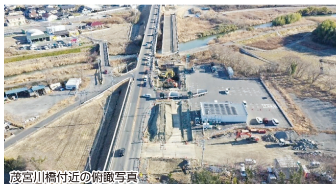
国道6号大和田拡幅の現地調査
