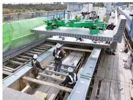
【新しい床版設置状況】
