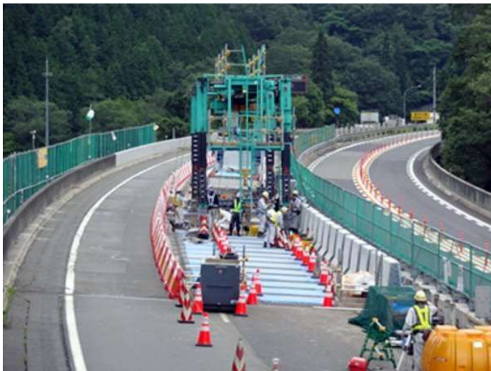
【終日車線規制状況】
