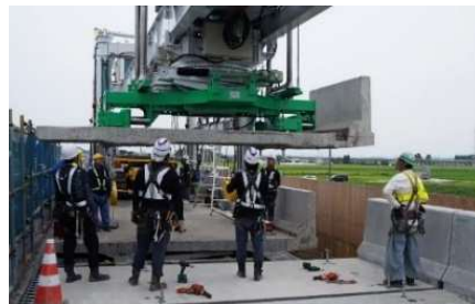
【古い床版撤去状況】
