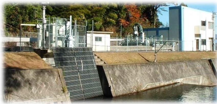
十王川取水口（十王浄水場）
