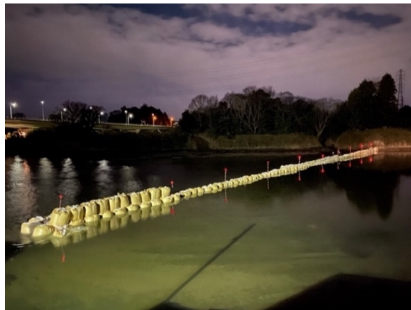
海水遡上対策として設置した土堰堤(久慈川取水場付近)
