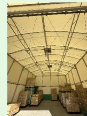
換気制御付換気扇を導入した倉庫
