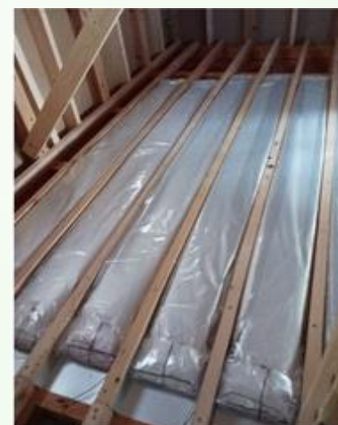
床下空調を利用した水蓄熱式床暖房「アクアレイヤー」
