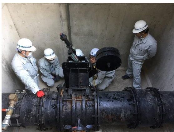
技術継承研修(サドル分水栓穿孔・配水池バルブ切替作業)
