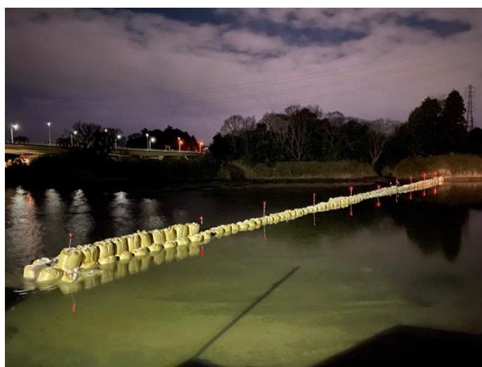
海水遡上対策として設置した土堰堤(久慈川取水場付近)
