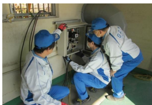
仮設制御盤設置訓練(会瀬ポンプ場)
