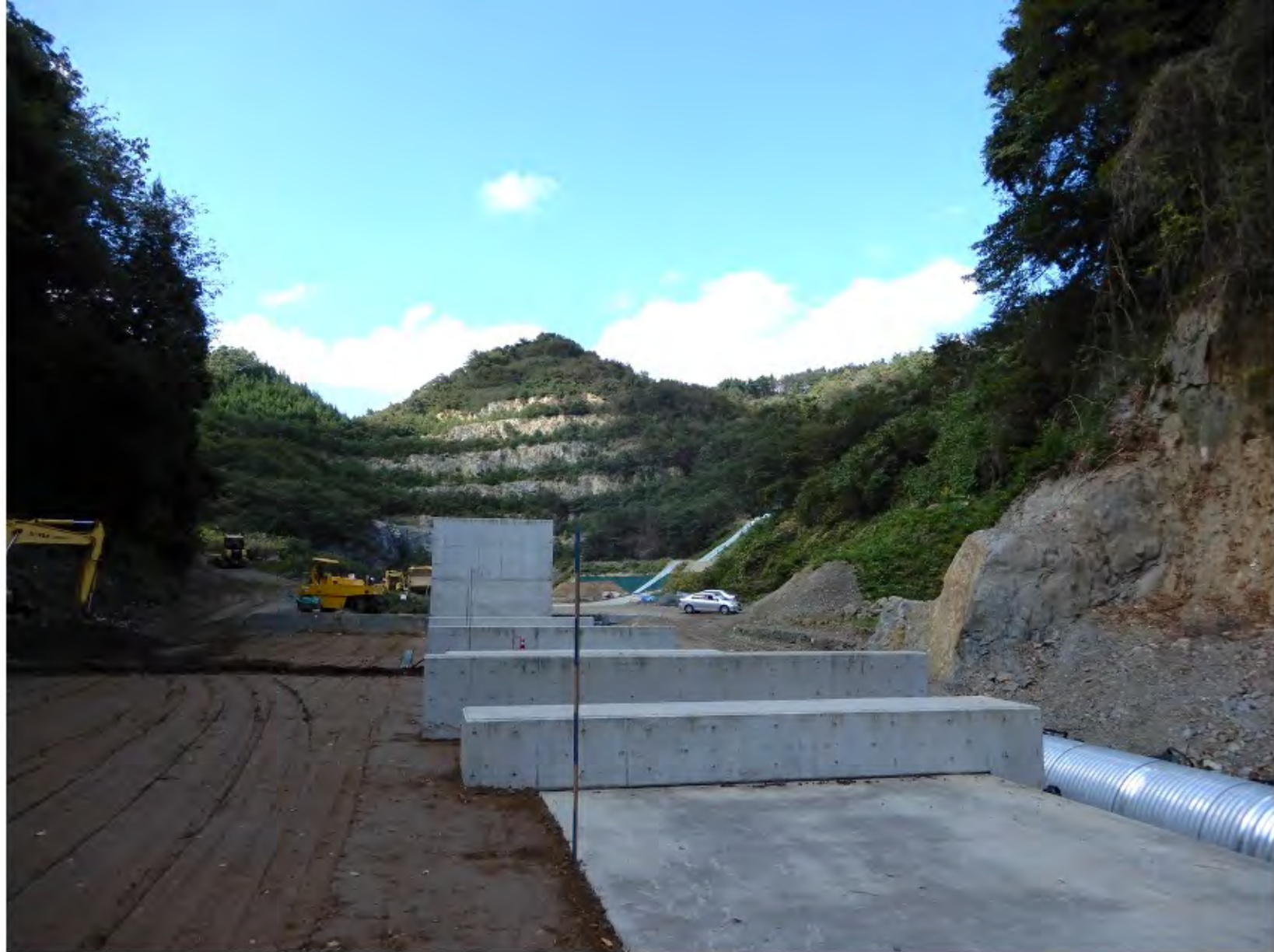
田尻川奥の防災工事
