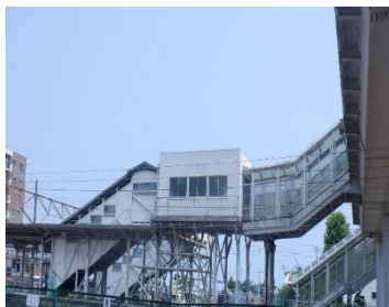
日立駅構内こ線橋撤去前
