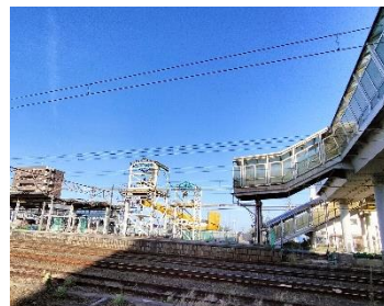
日立駅構内こ線橋現況
