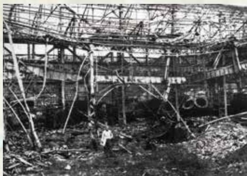
崩壊した海岸工場水銀整流器工場 （米国国立公文書館蔵）
