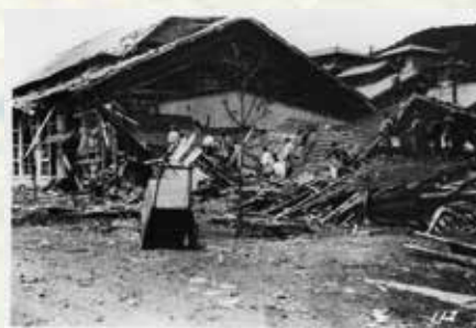
被災した日立工場青年学校の寮 (日立製作所日立工場提供)
