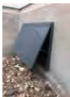
②浸水防止蓋設置
