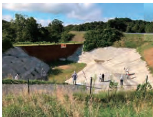
土砂等流出を防ぐ太陽光発電所の調整池
