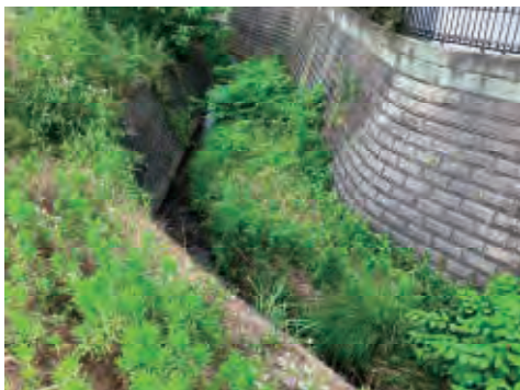
しゅんせつ 【浚渫前】
