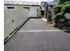
透水性アスファルト舗装
