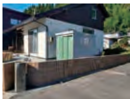
③浸水防止塀設置
