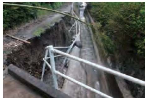
【平沢川(高鈴町)】 護岸背面の洗堀による護岸崩壊
