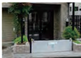
①防水板設置
