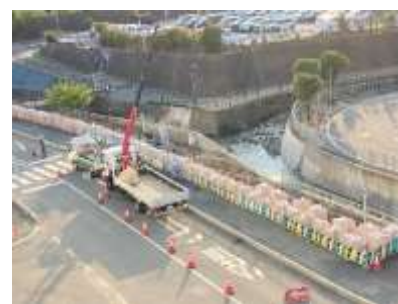
大型土のうの設置
