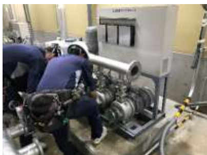
給水ポンプの復旧
