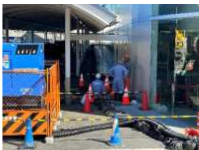
地下階に堆積した泥の排出
