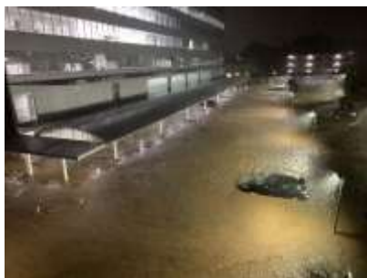
庁舎西側の浸水
