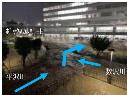
河川合流部から溢水
