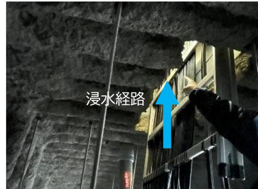
通信設備がある電気室の床貫通孔
