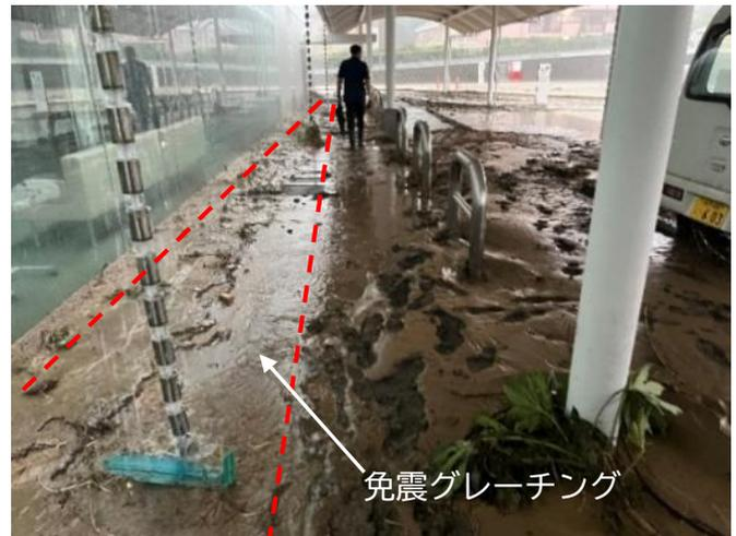
ウ 地下駐車場から地下1階への浸水経路
