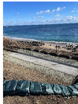
【本復旧工事後】
