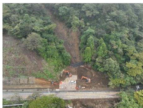
【清掃センター前 市道】
