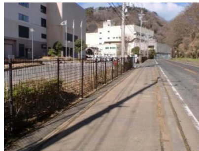
【本復旧工事後】
