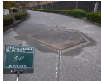
【本復旧工事後】
