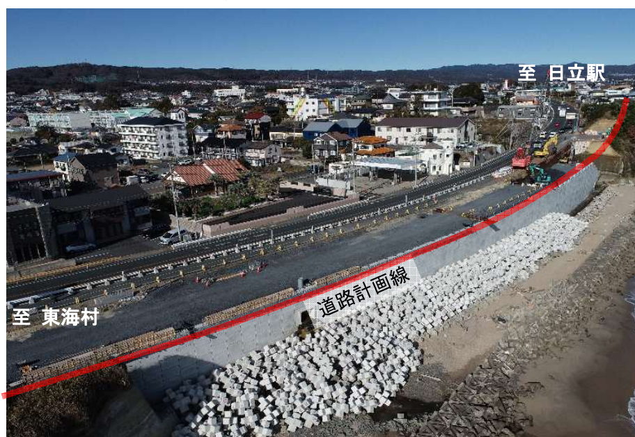
【国道245号日立港区北拡幅】 大みか駅入口交差点付近 上空から
