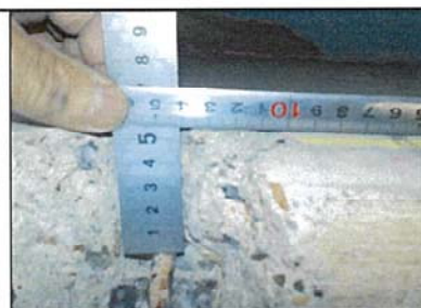
鉄筋発錆状況
