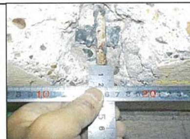
鉄筋発錆状況
