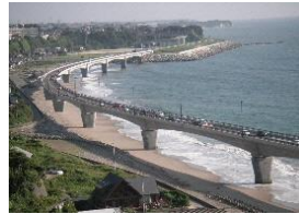
国道6号日立バイパス (シーサイドロード)
