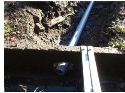
導水管が地中で破損しているため、水路の泥上げをしても、水がほとんど流れていないことが判明。機械で掘り起こし、新しい管に取り替えました。取水部のストッパーなども作りかえました。
