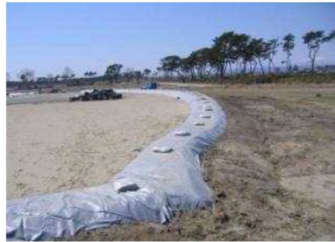
遮水シートを敷設した仮置場の事例 出典：仙台市HP
