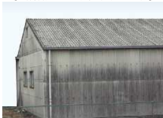
【石綿含有スレート波板（屋根・外壁）】
