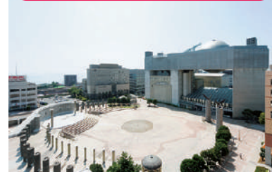
日立シビックセンター・新都市広場
