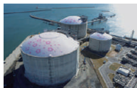
日立LNG基地 LNGタンクの大きさは、直径約90m、高さ約60mで、地上式タンクとしては世界最大級です。
