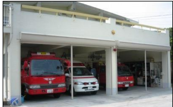
日立消防署西部機関員派出所
