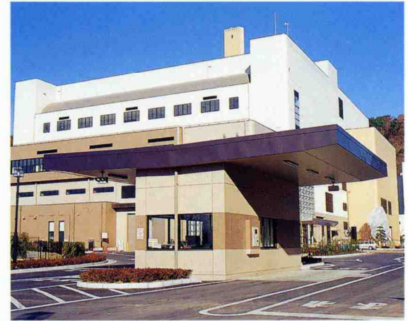
A 計量機 搬入されるごみの重量を計量し、コンピュータでデータ管理します。
