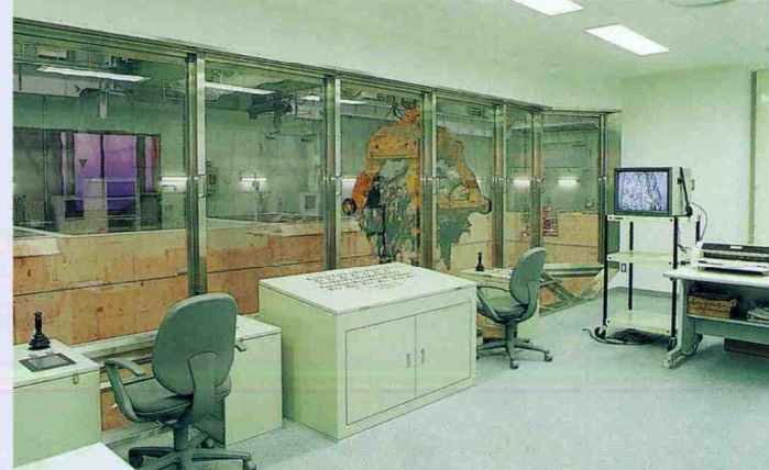
⑦ごみクレーン操作室 ごみピットに貯留されたごみを焼却炉に投入したり、ごみの攪拌、積み替えの作業を自動運転で行います。
