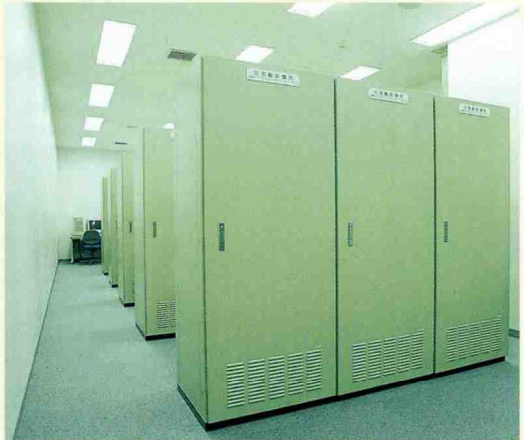
⑥電子計算機室 施設内の様々な機器の運転操作及び監視に関する情報の収集・処理をコンピュータが行います。
