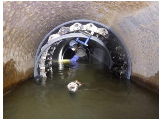
【寿命を延ばすための工事】
