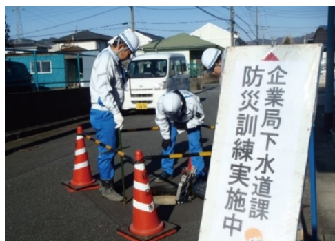
マンホール内目視点検訓練
