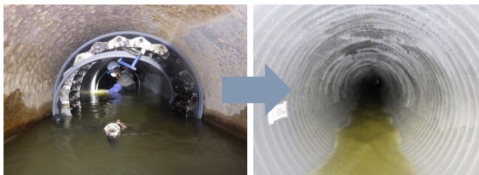
管渠改築工事
