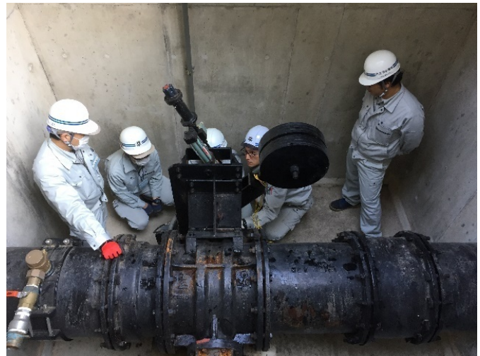
技術継承研修(配水池バルブ切替作業)
