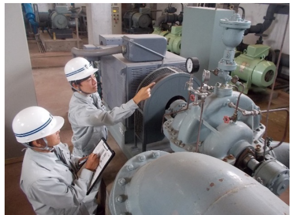
ポンプ設備点検(会瀬配水池)
