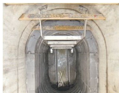
(出典)浮上防止マンホール工業 浮上防止(インナーウェイト工法の例)
