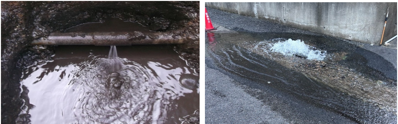
漏水が発生した水道管
