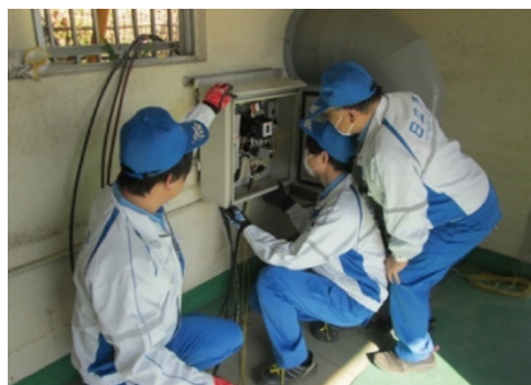
仮設制御盤設置訓練(会瀬ポンプ場)
