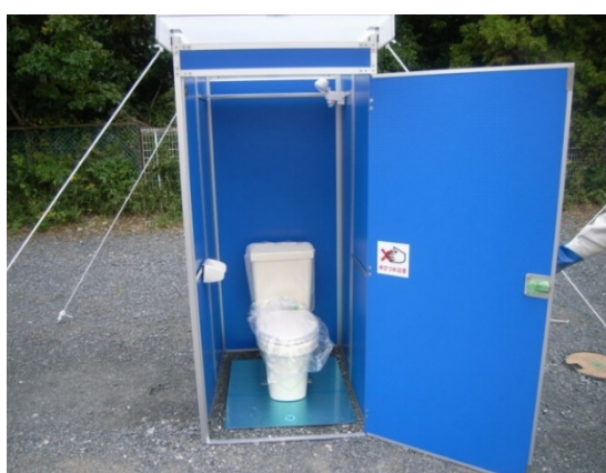
マンホールトイレの便座とパネルを設置した
