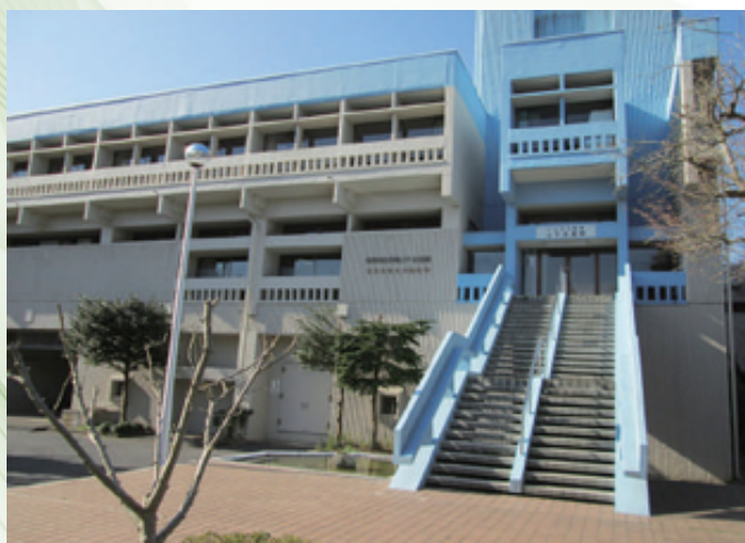
池の川処理場(管理棟)
