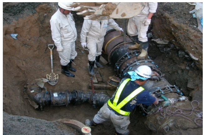
配水管漏水修理(小木津町)
