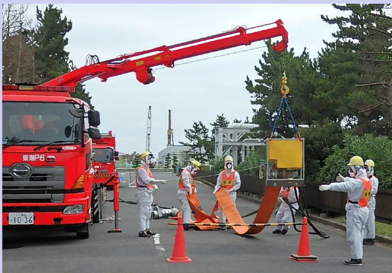
可搬型代替注水ポンプ車の設置・運用
