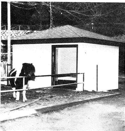
12 / 24新しく完成された ポニー舎
