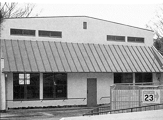
▲の外壁が きれいになりました
