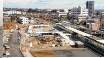
西口駅前広場(工事の状況)
