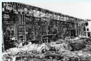
破壊された日製多賀工場 写真：日製多賀工場提供
