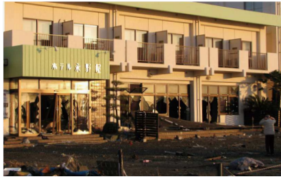
ガラスが割れ、駐車場には物が散乱
