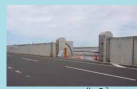
防潮壁・陸閘
