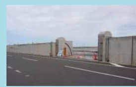
防潮壁・陸閘
