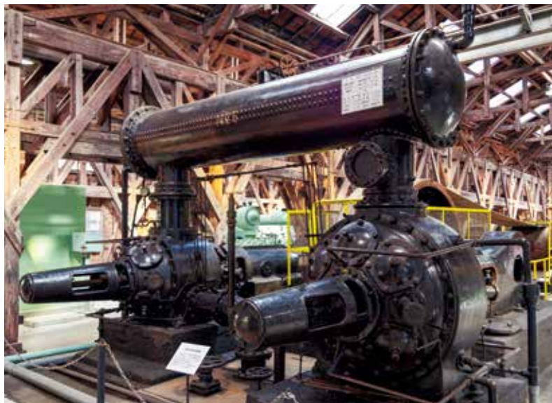
↑閉山まで使用した450馬力のコンプレッサー。
