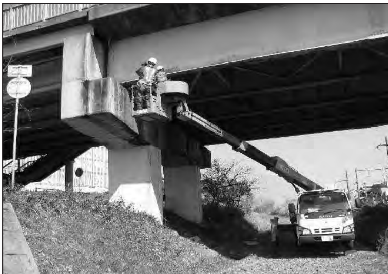
高所作業車による近接目視点検の様子（水木こ線橋）
