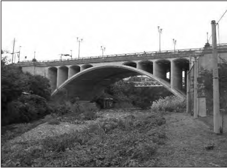
予防保全Ⅰ型管理橋（宮田川橋）
