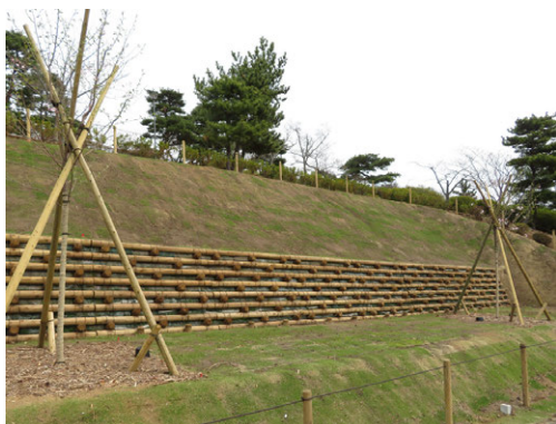
植栽基盤の整備と桜の更新
