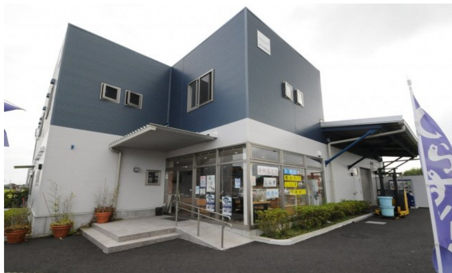
国の復興交付金を活用し、水産業共同利用施設復興整備事業で整備した「水産加工流通施設」
