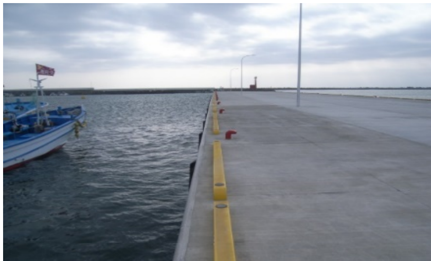
震災の被害を受け、改修した「久慈漁港」
