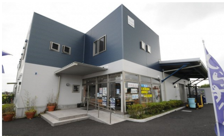
国の復興交付金を活用し、水産業共同利用施設復興整備事業で整備した「水産加工流通施設」
