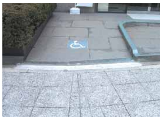
店舗入り口の段差解消
