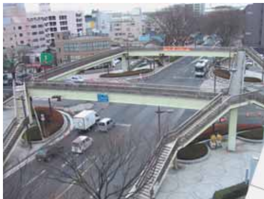
高齢者、身体障害者等の移動の円滑化を図るため、上下方向の移動が伴わない横断歩道を設置
