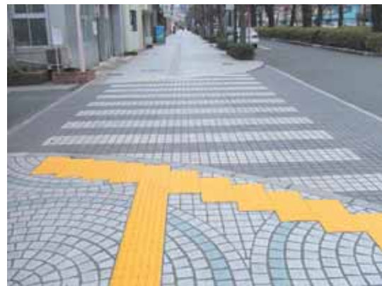
接続道路を嵩上げし、歩道の連続性を確保したスムーズ横断歩道
