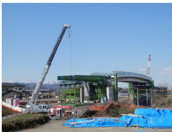
細田踏切～森山架道橋（二線橋）
