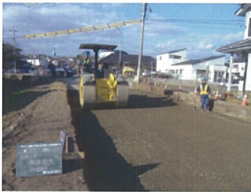
（道路の路盤を造っています）
