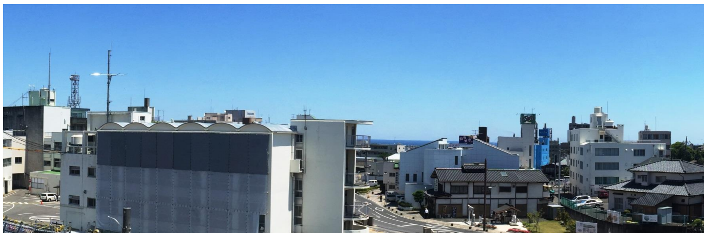
■4階からの風景 床コンクリートの打設が完了した4階部分から海側を見えています。 鉄骨工事は、空と海の水平線が見える高さまで進んでいます。
