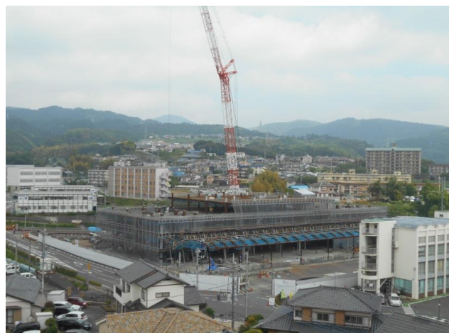
■全体工事風景 南側から工事現場を見えています。
