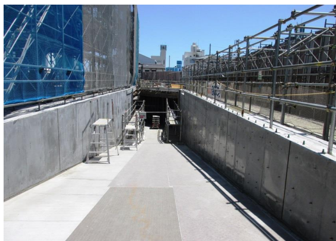
■車路壁のコンクリート打設 車が地下1階に出入りするための車路の壁を打設しました。
