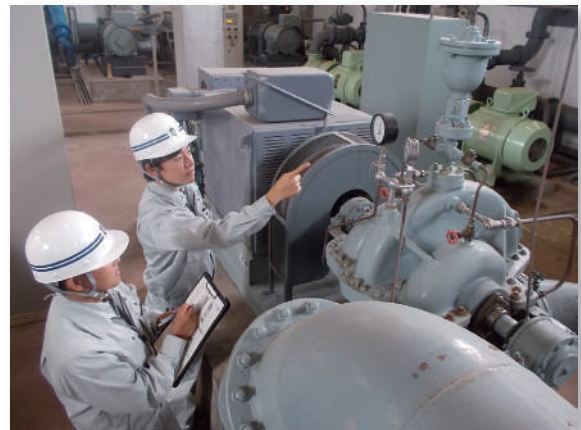
ポンプ設備点検(会瀬配水池)
