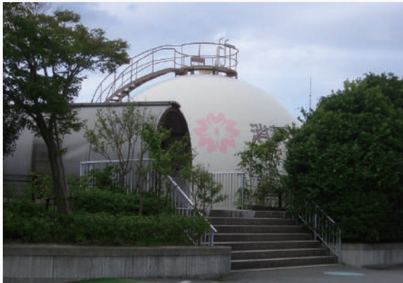
消化ガスタンク
