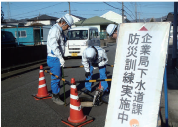
マンホール内目視点検訓練
