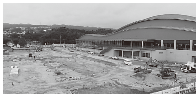
駐車場整備工事等が行われている池の川さくらアリーナ
