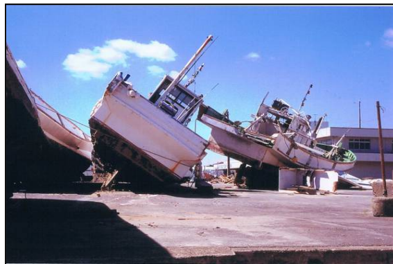
▲久慈漁港の津波被害
