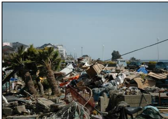
▲河原子海岸の津波被害
