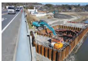
国道6号大和田拡幅工事
