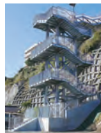
津波避難 階段の整備
