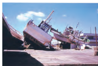
久慈漁港の津波被害
