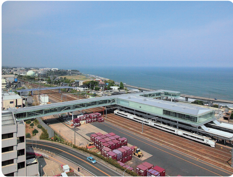
日立駅自由通路及び橋上駅舎
