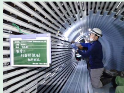
雨水管渠改築工事
