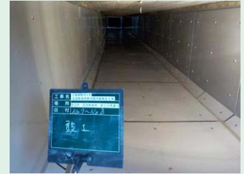
流下能力を向上させる「内面更正工法」
