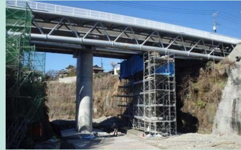
大学橋修繕工事
