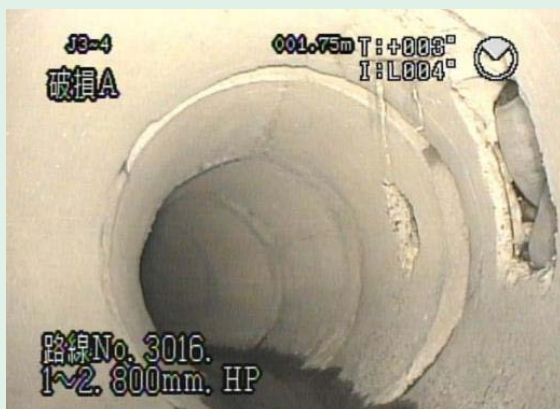
道路埋設管劣化度調査
