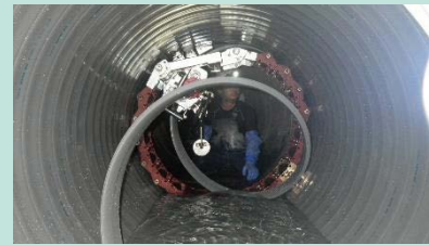
雨水管渠改築工事
