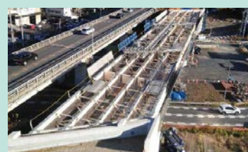
国道6号大和田拡幅事業
