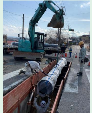
管路更新工事
